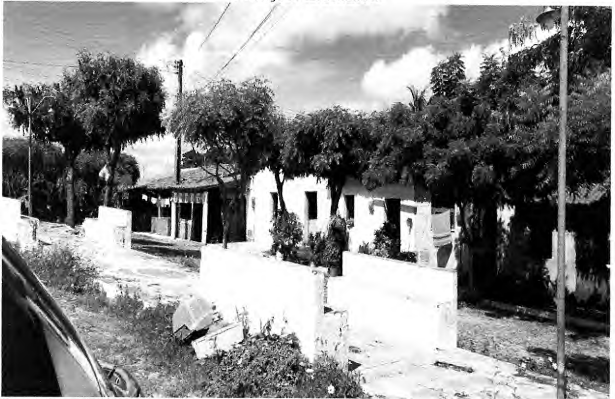
Demolições de pisos, bancos e remoção de portes
